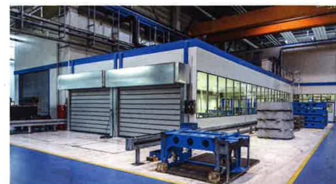
Insgesamt entstand eine U-förmige Systemraumanlage aus dem Klimaraum (rechts im Hintergrund), dessen Vortemperiererraum (Bildmitte), dem Messraum sowie dessen Vortemperiererraum (links im Hintergrund).
