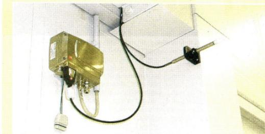
**Luftfeuchte wird auf Umwegen erfasst:** Nur über Taupunktfühler lassen sich Feuchtigkeiten unter 2 % zuverlässig bestimmen. Foto (2): Nerling Systemräume
